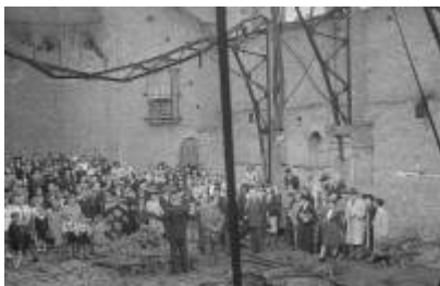
Bildunterschrift: „Aufnahmen der zerstörten Baptistenkapelle in der Badstraße in Berlin“
