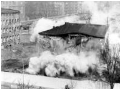
Sprengung Altbausubstanz Müllerstr. (1975)
